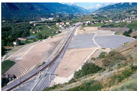
Double voie Salgesch-Leuk, Remblai Salgesch
