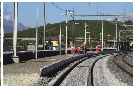
Double voie Salgesch-Leuk, Gare de Salgesch
