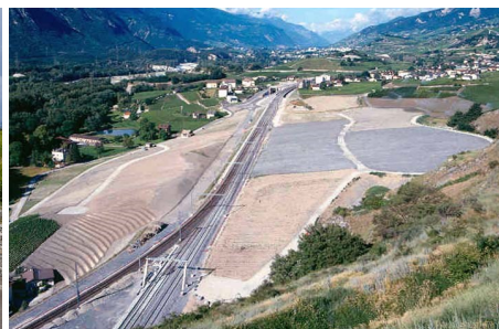
Double voie Salgesch-Leuk, Remblai Salgesch
