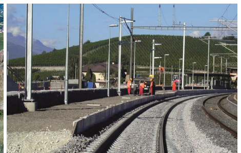
Double voie Salgesch-Leuk, Gare de Salgesch
