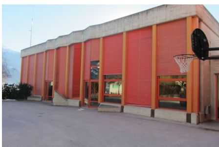
Mise en conformité de la salle de gym de l'École de Veyras
